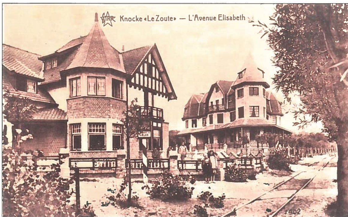
Typische kustarchitectuur in het Zoute langs de Elizabetlaan ter hoogte van het Cottagepad en het General Lemanpad. Vooraan de villa 'Le Gîte' uit 1923 ( gesloopt). Het pension 'Les Pétrels' werd 'Hôtel Élysée' tot aan de sloping in 2000. Er kwam een retro Anglo-Normandische cottage-bouw met sierlijk torentje en doorlopend overdekt terras.
