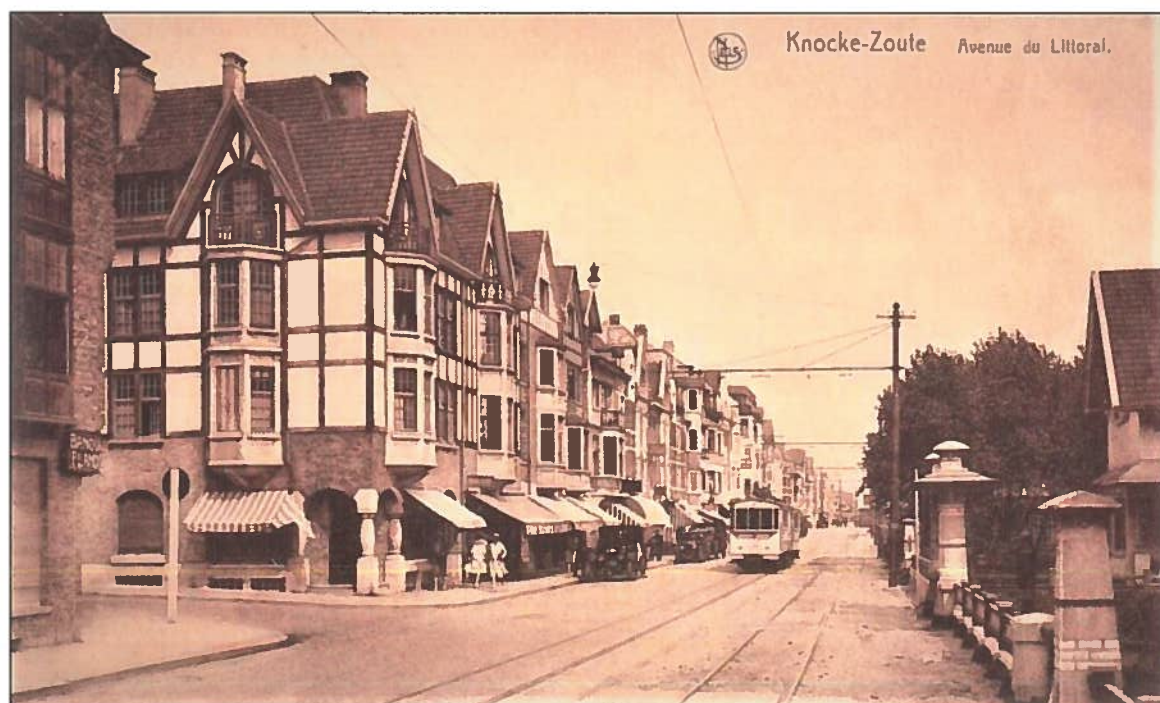
De Kustlaan ter hoogte van de Zeewindstraat met op de hoek het 'Westminster Hotel' in cottigestijl. Het gebouw werd in de late jaren '20 opgericht (gesloopt 1952). De elektrische tram volgt zijn spoor.
