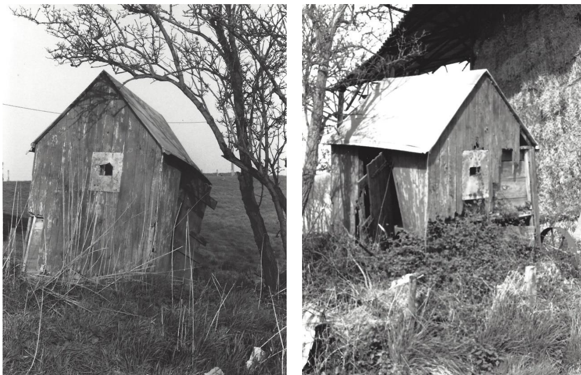
Twee foto's van de kavane in 1990, voor de restauratie door de Provincie West-Vlaanderen.
